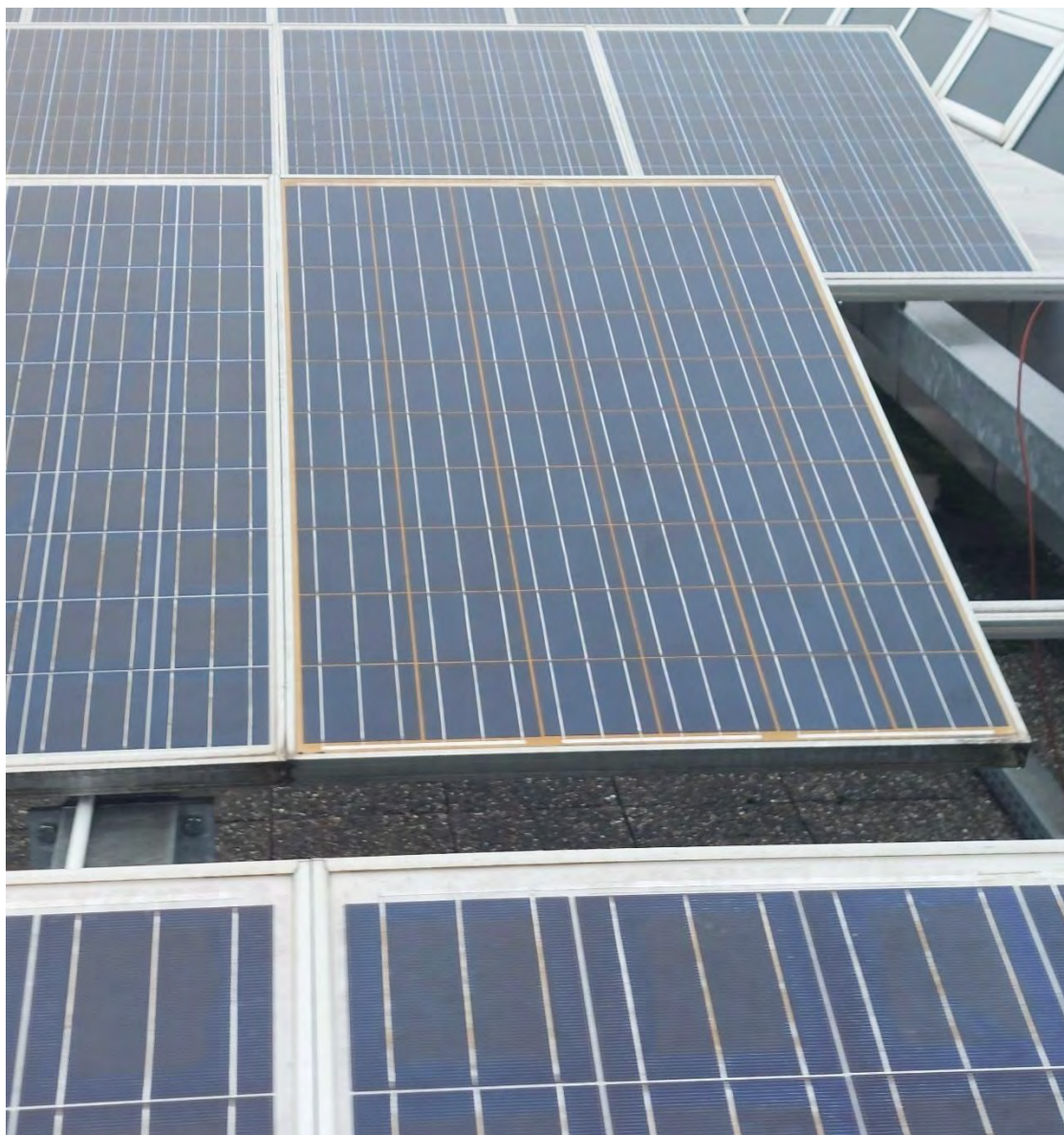
– Moduli con segni di deterioramento nei contatti tra celle FV
